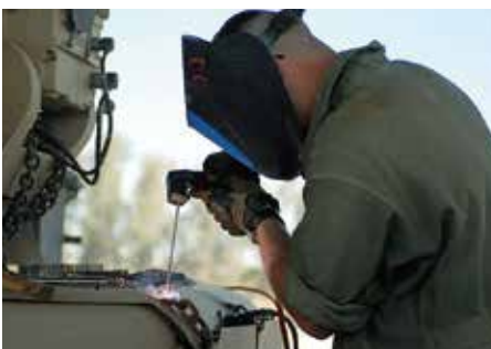
被覆アーク溶接作業
