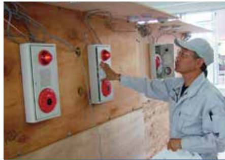
消防設備保全部作業
