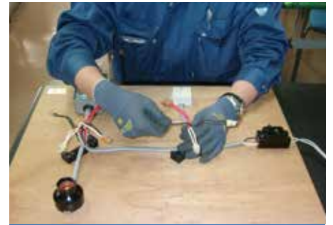
電気工事配線作業
