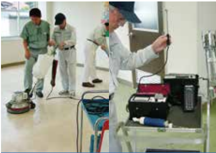
ビル管理基本作業
