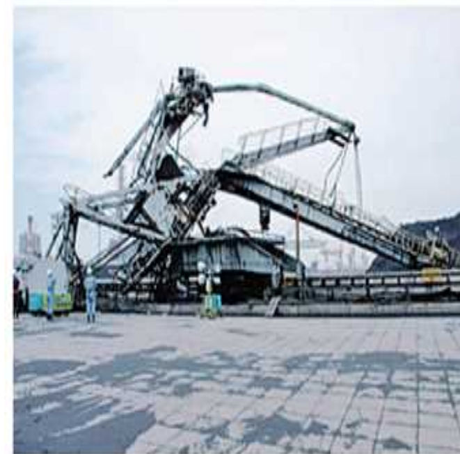
クレーンの崩落災害
