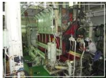
主発電機関の整備工事を運行中の船内 作業にて行いました
