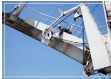
フェリーに車が乗船する際に使う可動橋です ワイヤーとワイヤーが通る滑車を交換しました
