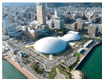
あなぶきアリーナ香川（電気設備工事）
