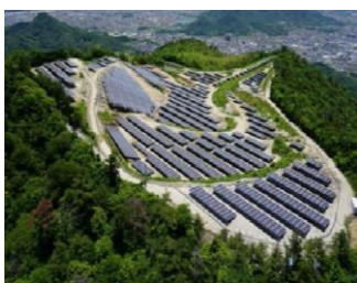
いちご高松国分寺町様（太陽光設備工事）
