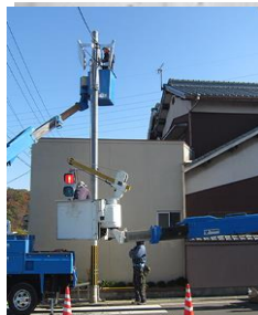
公共工事（電気・通信）
