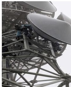
情報通信設備工事
