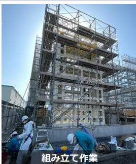
組み立て作業
