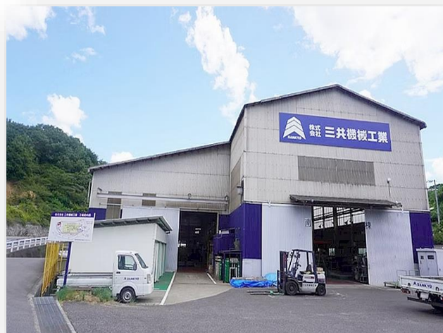
三共機械工業 神山工場 外観
