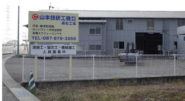
高松工場外観
