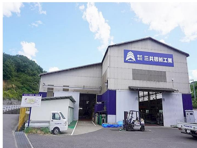
三共機械工業 神山工場 外観
