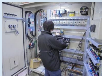
作業風景：配線作業
