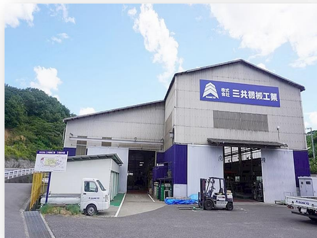
三共機械工業 神山工場 外観
