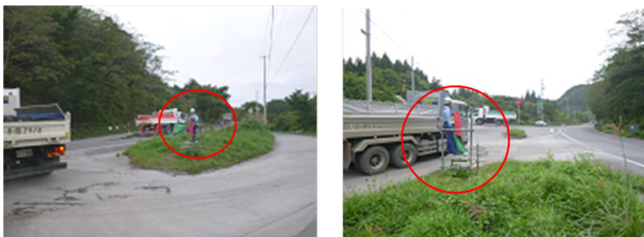
交通整理員と単管足場
