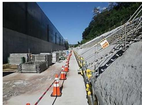
事例の概要 施工ヤード及びフーチング上端部を「安全通路」として工事用車両との接触事故、足場からの飛来落下物による事故防止に努めた。
