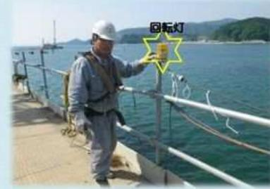
事例の概要 | 限られたスペースの中、パイプの騒音でOPへの合図が取りにくいので、回転灯により合図を「見える化」する。
