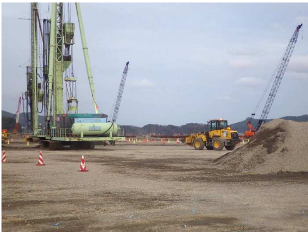
タイヤショベルローダー稼働状況
