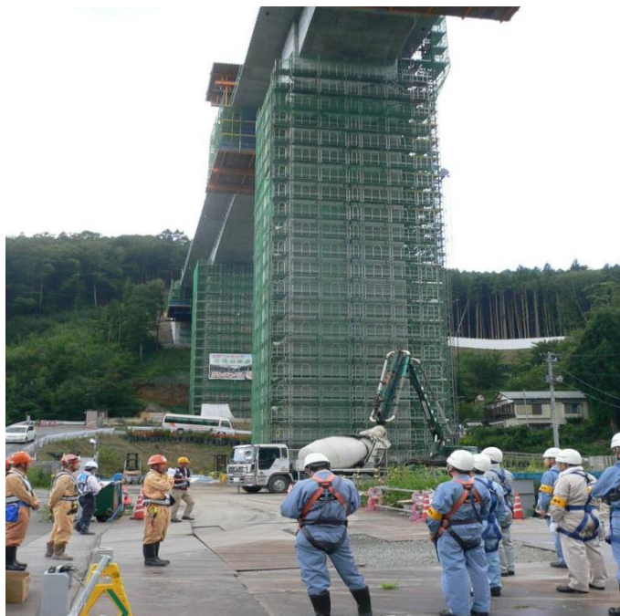
橋梁に昇る前でも施工業者から詳細な説明を受ける様子
