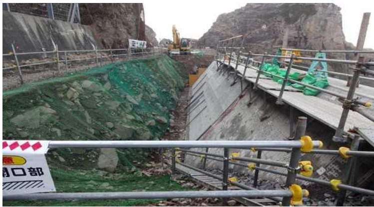
※足場は組立て途中
