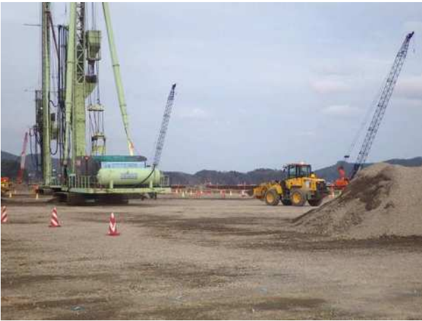
タイヤショベルローダー稼働状況
