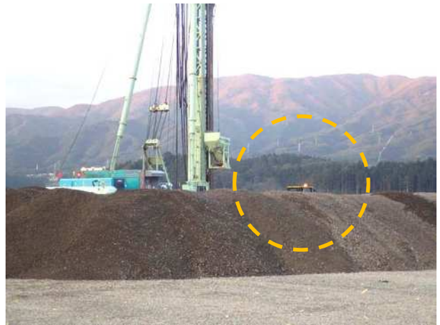
タイヤショベルローダーのパトライト視認状況
