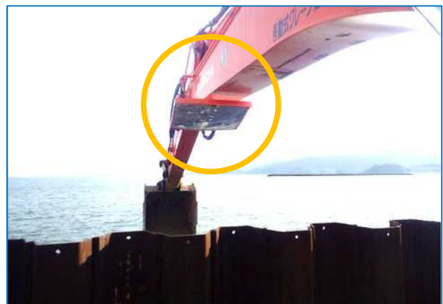
バックホウミラー取付け状況
