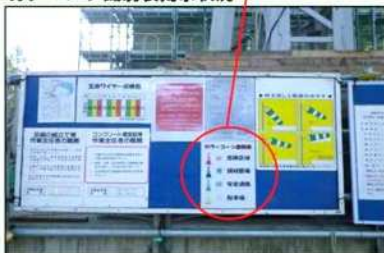
カラーコーン識別表掲示状況
