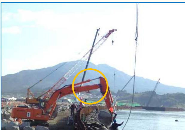
バックホウミラーによる作業状況
