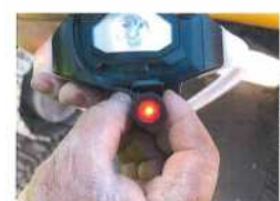
フェイスランプ点灯 作業員がバックホウ作業半径内に侵入したことを認識
