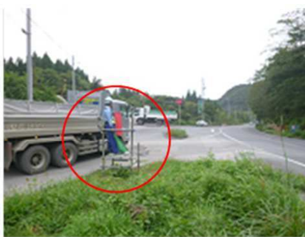
交通整理員と単管足場
