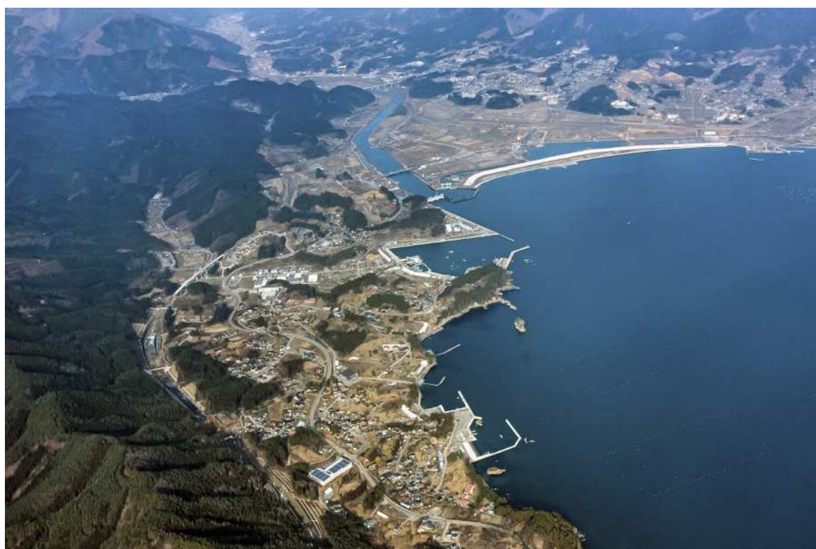
『陸前高田市内』写真提供：飛鳥建設（平成28年12月）
