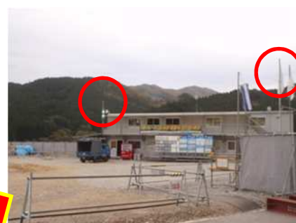
吹流し拡大状況
