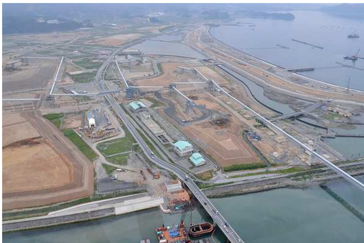
『気仙大橋（陸前高田市）』写真提供：東海新報社
