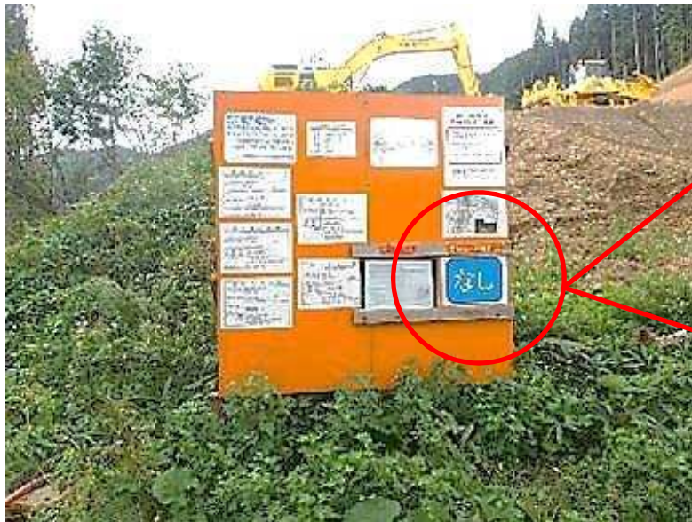
【現場入口揭示板】
