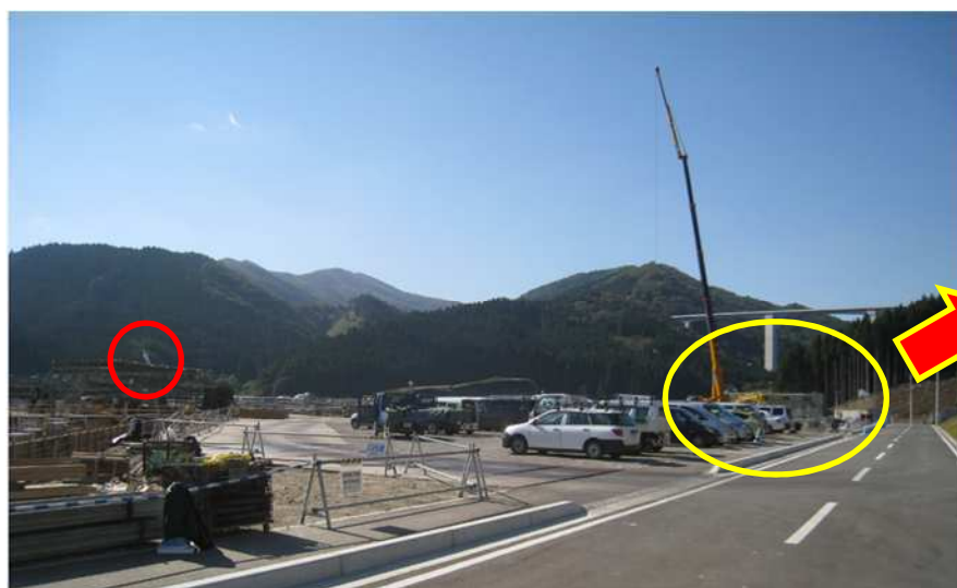
吹流し 3 箇所設置 風速計 1 箇所設置
