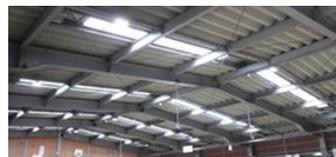
ホームの天井に、「天窗」を設け、更に照明を全てLEDに変更し、照度を高め、床面の視認性を向上させている。
