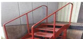
トラックホームから降りる際の転倒防止対策として、階段の設置に加え、両サイドに手すりを取り付けている。
