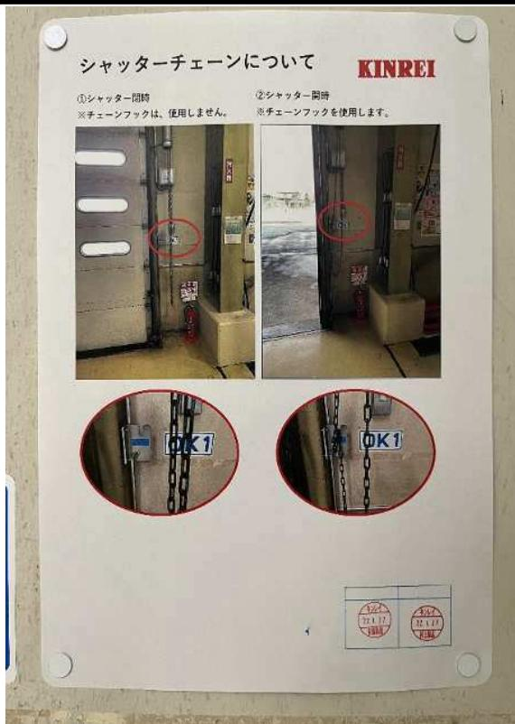
水圧開錠シャッターのチェーンの状態を写真付きで表示している。
