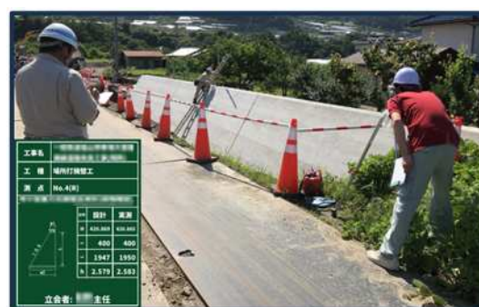
「電子小黑板ソフト」使用状況 （作業員が現場で実際に黒板を持つことなく、同様の撮影ができる）
