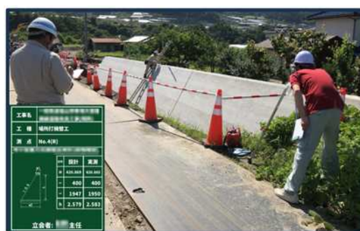
「電子小黑板ソフト」使用状況 （作業員が現場で実際に黒板を持つことなく、同様の撮影ができる）
