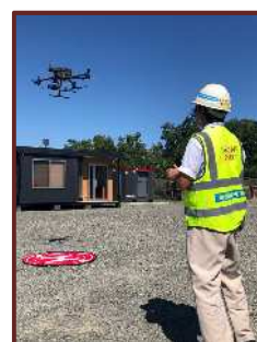
ドローン測量の様子
