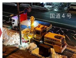
②ローリー除雪車でダンプトラックに積み込み
