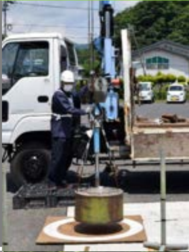
小型移動式クレーン
