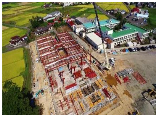
福祉施設新築工事現場
