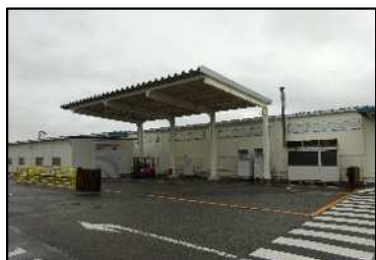
門扉を開けた状態
