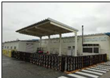
門扉を閉めた状態
