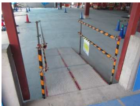
写真.仮設スロープ
