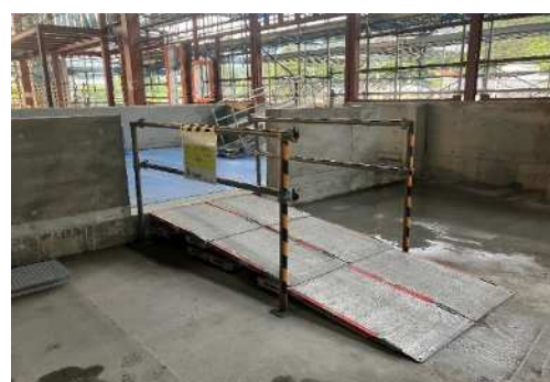
写真.単管手摺による転倒防止措置
