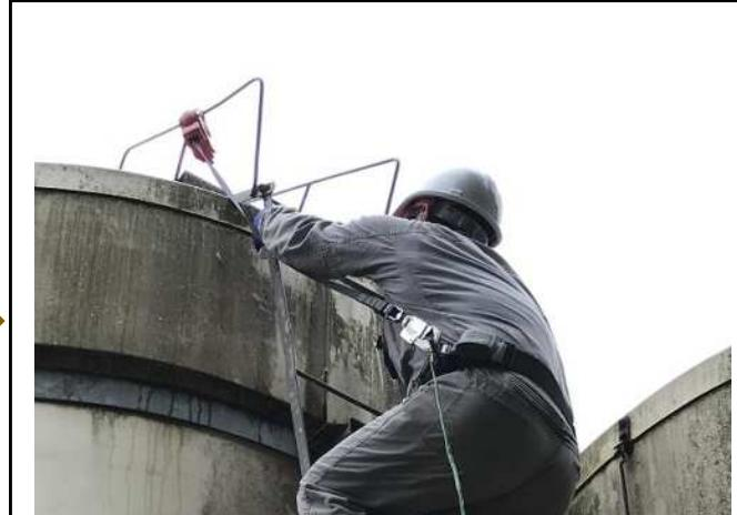
サイロ上部の手すりに安全ブロックを設置し、墜落を防止している。
