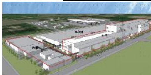
北上工場新棟 2024年9月稼働予定
