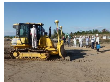
▲ICT-MC建機(ブルドーザ)の実践
