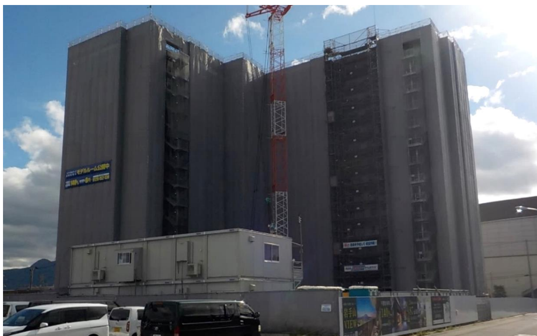
パトロール現場（R8.6.9 北東側より撮影）
