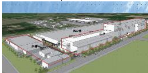
北上工場新棟 2024年9月稼働予定
