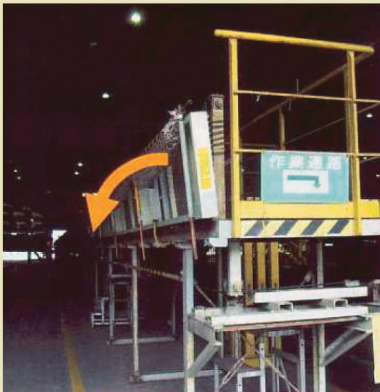
作業床を使用する前
