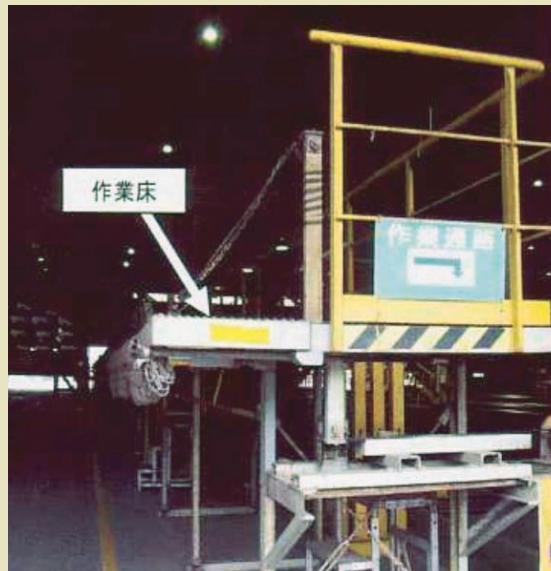
作業床を使用
