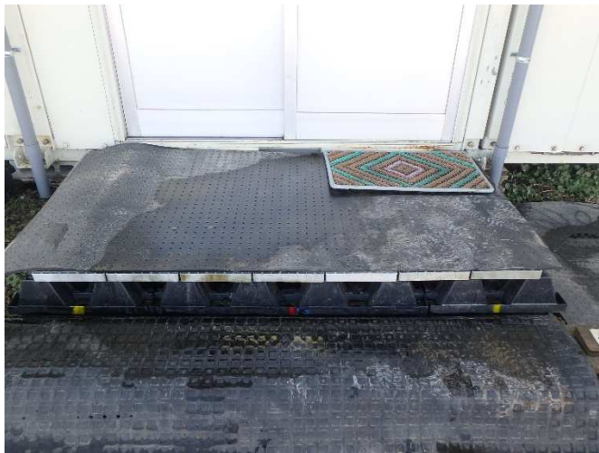
休憩所入り口段差解消と滑り止めゴムマット敷設
