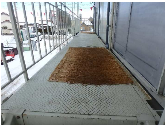
雪や凍結によるスリップ防止にムシロを敷設
