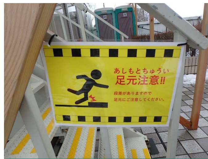
踏板上に滑り止めテープを貼り滑っての転倒防止
