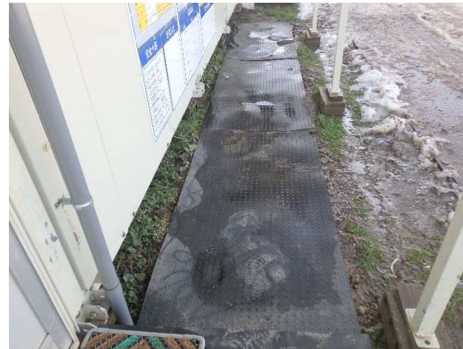
歩行通路にゴムマットを敷設して鉄板上での転倒防止
