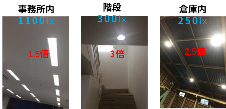
照明器具（蛍光灯・水銀灯）をLED照明に取り換え
