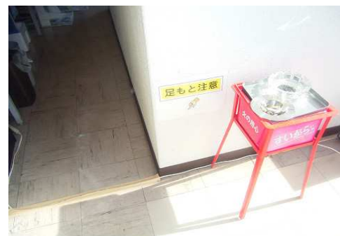
廊下の配線を養生と注意喚起の表示
