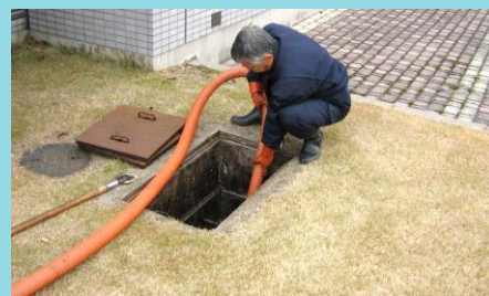
▲浄化槽の中にたまった汚泥を吸い上げる様子
