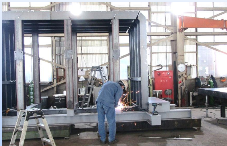
溶接作業の様子。厚板溶接。
