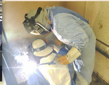
電気溶接職種
