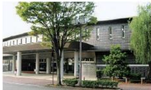
県内窓口 ＜金沢・本多の森庁舎＞ (H28～)
