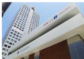
ILAC東京 ＜東京駅日本橋口＞ (H28～)
