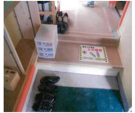
きれいに整理された工事中の建物の玄関
