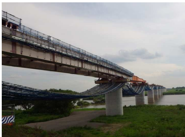
建設中の圏央道利根川高架橋
