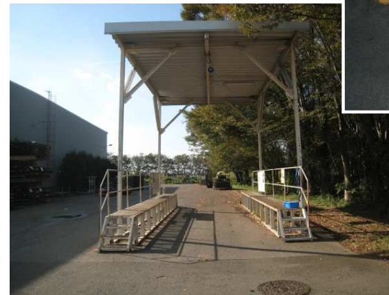
(左) 荷積み専用プラットホームの設置例
