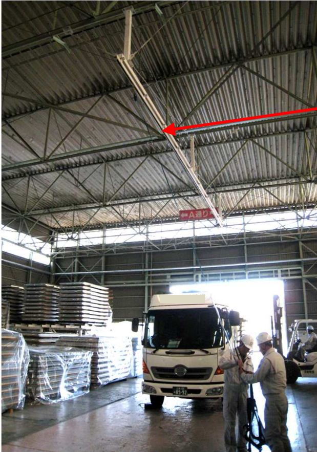
(左)安全帯取付設備のレールの設置例。 荷台上で作業する時はハネス型安全帯を使用する。
