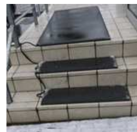
< ヒートマットの設置例 >
