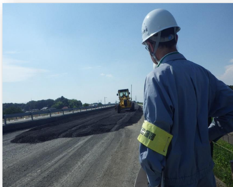
重機作業を確認する山口署長
