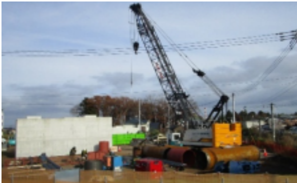
工事現場全景
