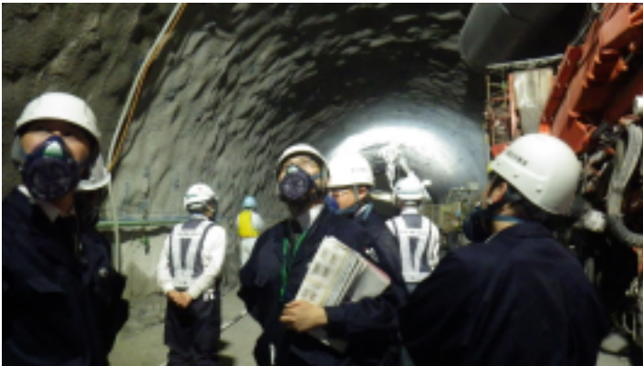
上曽トンネル工事現場(茨城県桜川市)
