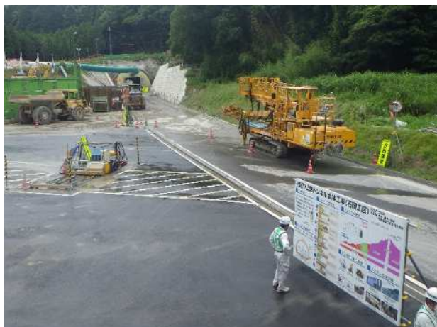
整理整頓が徹底された工事現場
